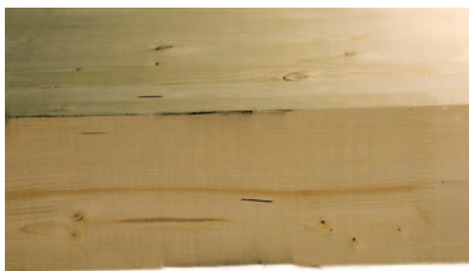
Bild 13a, b Hebevorgang; unzulässige Eindrückung durch Gurte
